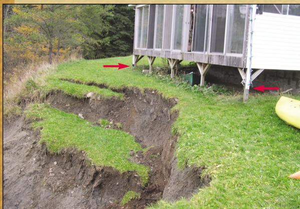
Gouttières (flèches) non raccordées à un tuyau allant jusqu'à la base du talus ou à un égout pluvial
