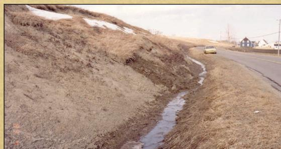
Excavation à la base d'un talus ayant provoqué un glissement
